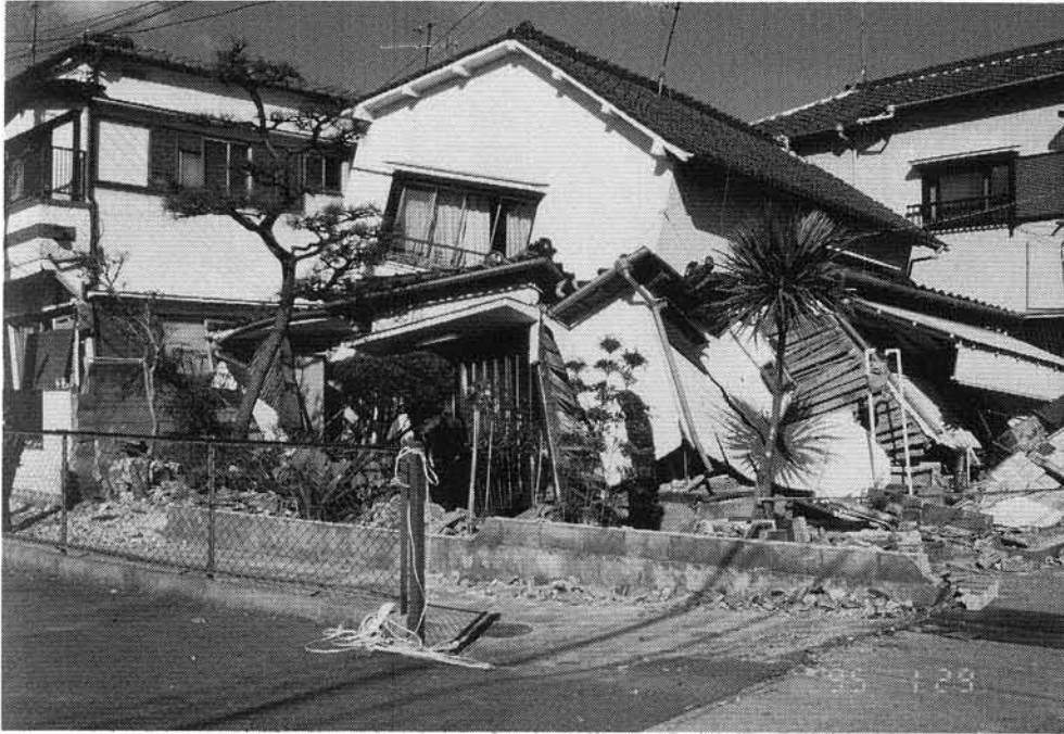
31 木造住宅倒壊 高架部分崩壊 ・1995. 1. 29. (日) ・これも1階が潰れている。
