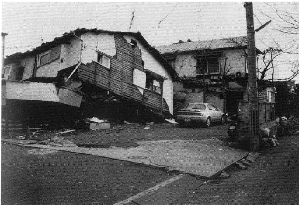
32 木造住宅倒壊 ・1995. 1. 29. (日) ・1階が潰れている。 延焼防止のためのラス モルタル仕上は落ちてしま まい、この状態で火災にな ったら何のためのラスモル タルだかわからない。
