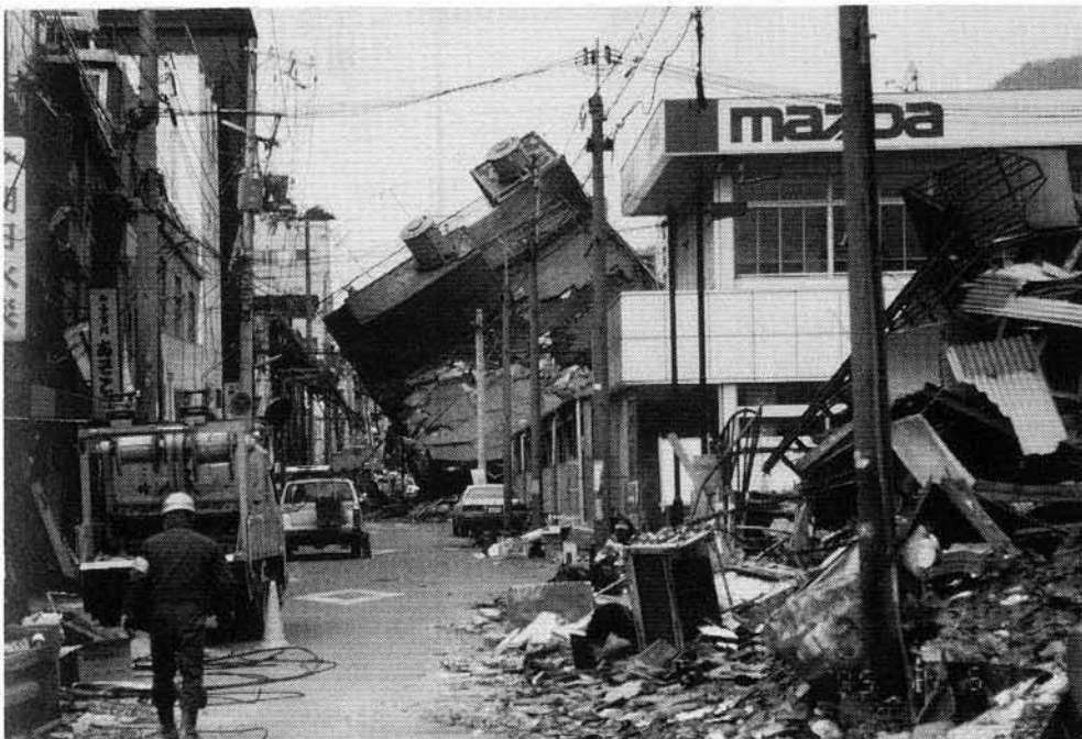
68 66に同じ ・ビルが倒壊したう えに、焼けている。 倒壊したビルの屋上 に水槽が落ちづにつ いているのが妙な感 じである。
