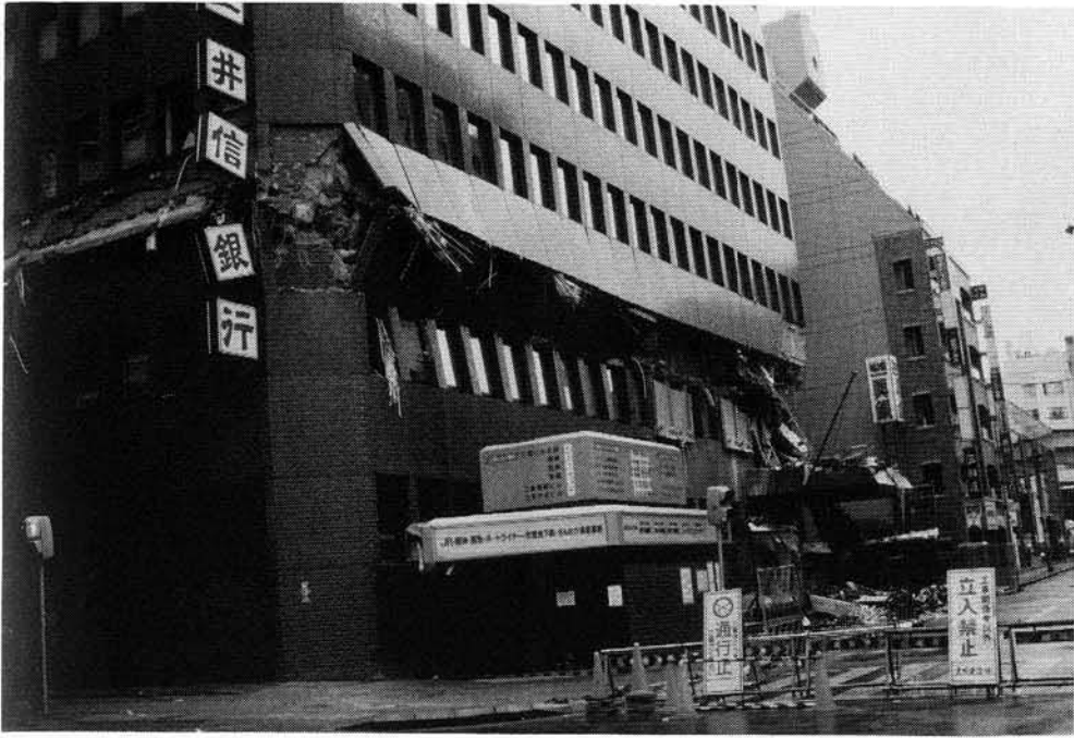
43 中・高層ビルの層崩壊 ・1995. 2. 4. (土) ・神戸市中央区
