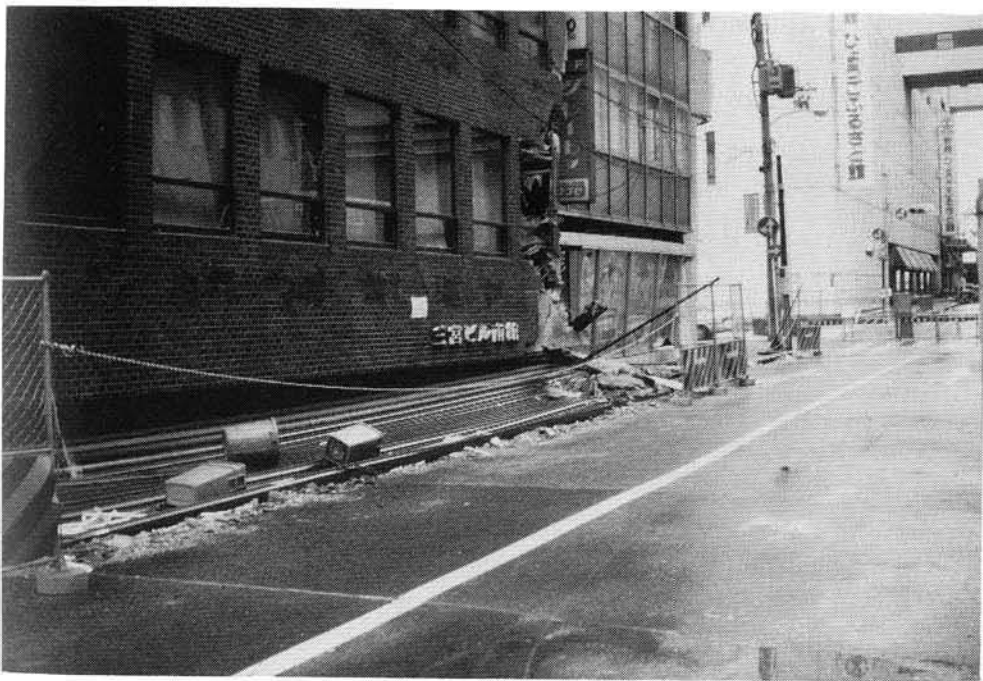
44 中・高層ビルの1階の崩壊 ・1995. 2. 4. (土) ・神戸市中央区 ・1階部分が全く崩壊してしまっている。 ビルの名前は1階エントランスの上にあったもの。 手前に鉄筋のように見えるのはシャッターのスラット。
